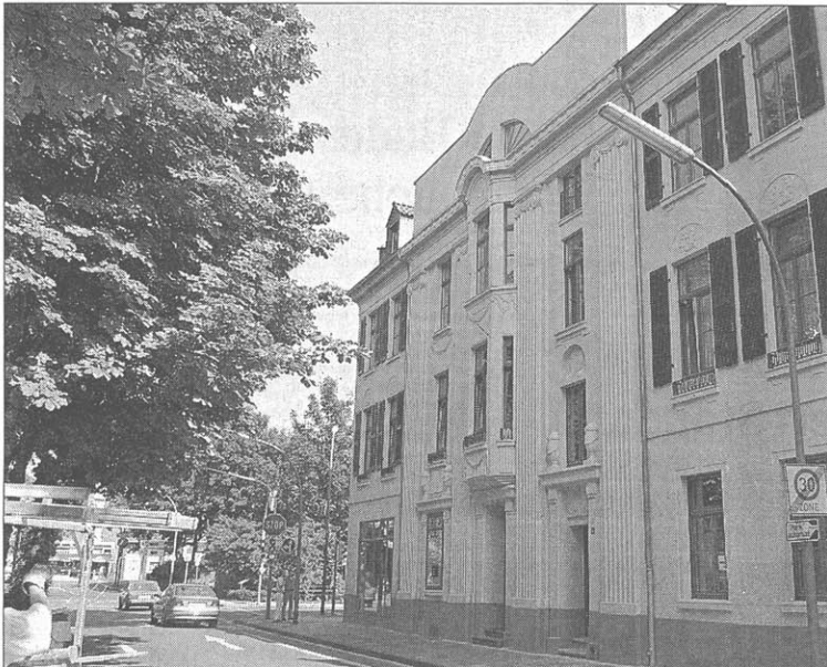
Das Haus an der Drususallee 8 ist für 2,2 Millionen Mark saniert worden. Unter anderem wurden der Außenstuck wieder in seine natürliche Farbe zurückversetzt und Fensterläden aus Miranti-Holz angebracht. Die ausführende Neusser Firma Concept West ist auf die Sanierung denkmalgeschützter Gebäude spezialisiert.
