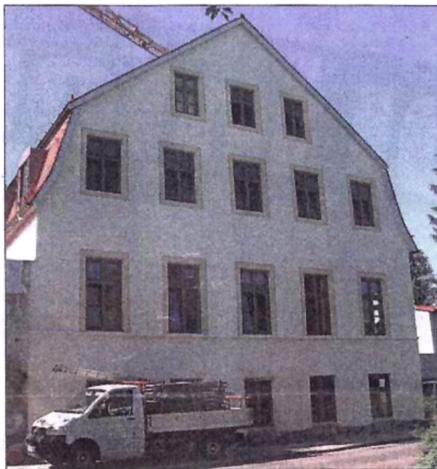
Das Neusöner Schloss wurde von der Eternit-Ver-schalung befreit. Foto: aha
